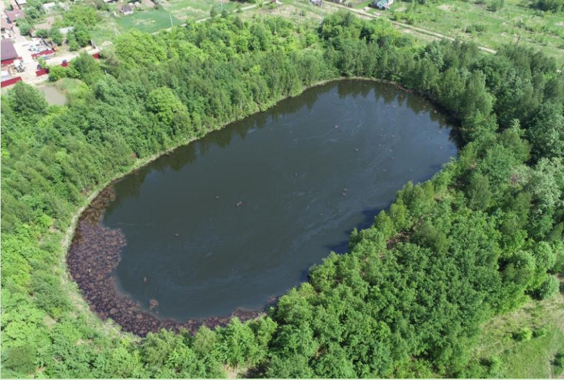
Мазутохранилище в г. Балахне
