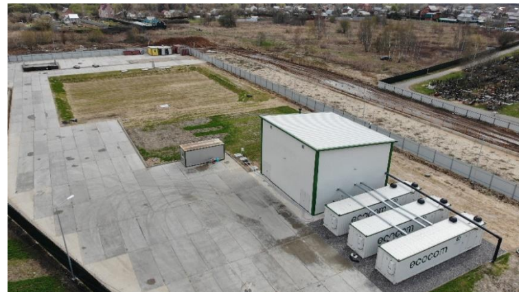
Очистные сооружения фильтра
