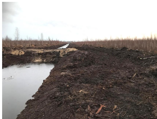
Глухая земляная перемычка с односторонним обтеканием
