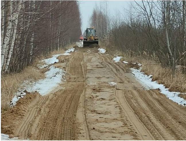
Усовершенствование подъездных путей
