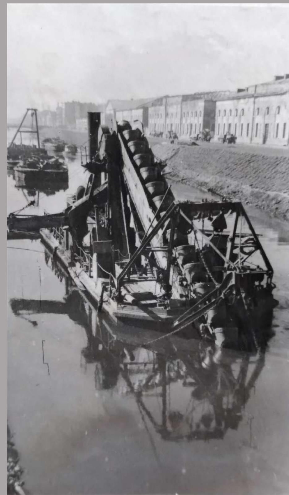
Управление «Ленводпуть» проводит дноуглубительные работы на Обводном канале в районе Варшавского вокзала. 1949 г.
