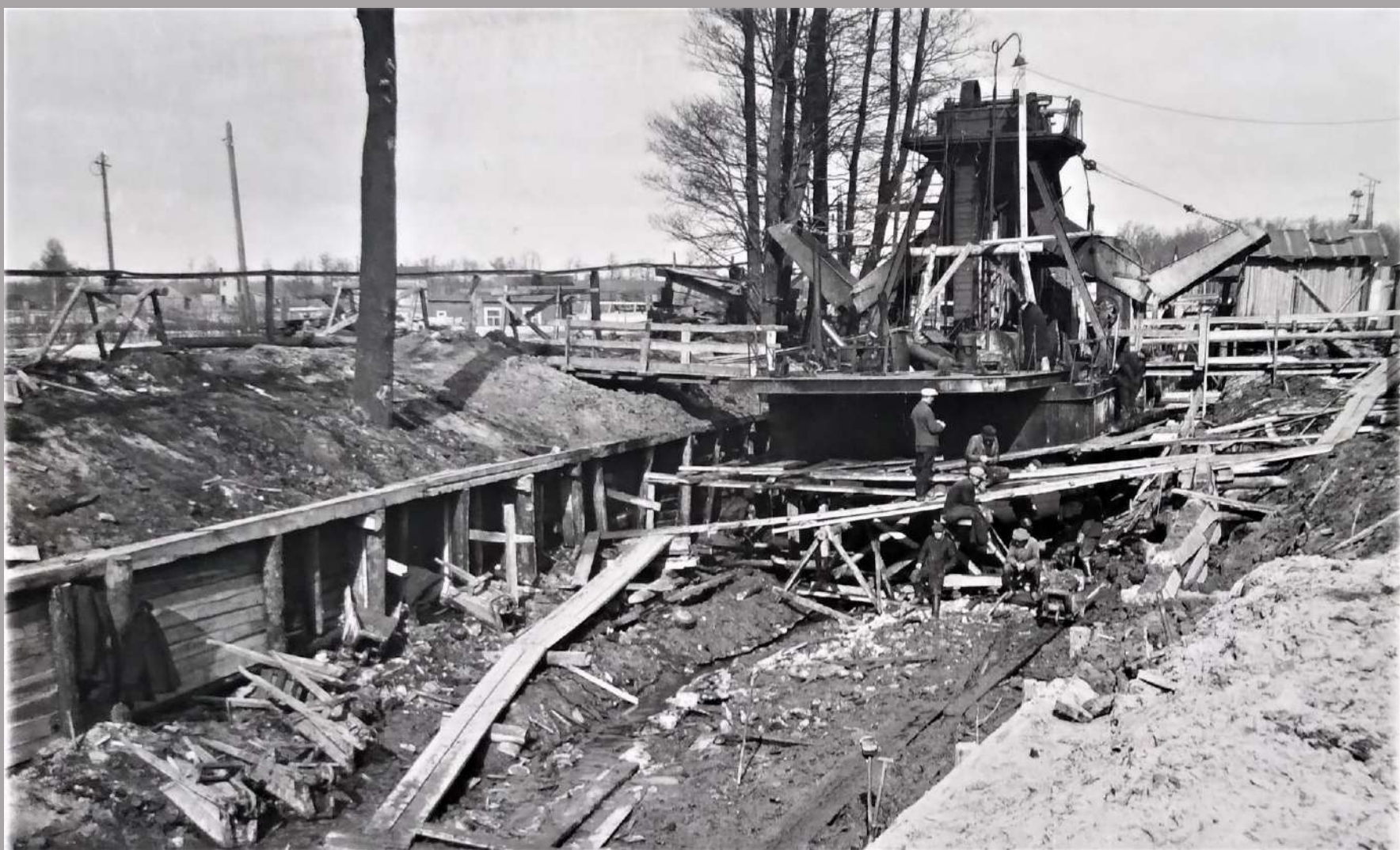
Трест Ленинградских водных путей. Вид работ по строительству судоходного канала. 1920-1930 гг.
